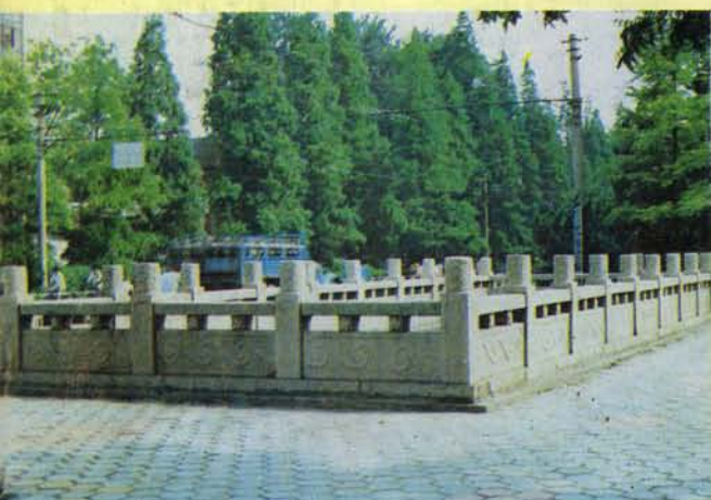
新改建的太平北路桥
