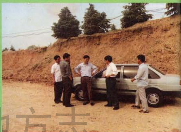
市、区、局领导查看宁丹公路施工情况
