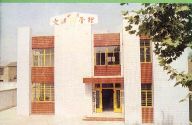
雨花台区西善桥交管所办公楼
