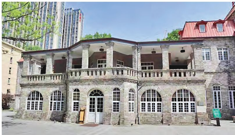
修缮完工的扬子饭店旧址
