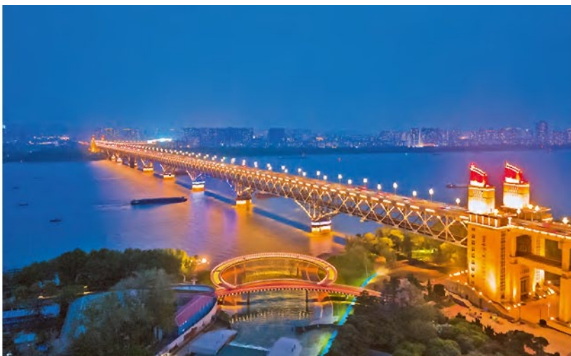
建成完工的长江岸线南京大桥公园段彩虹桥工程 (宁建新 供图)
