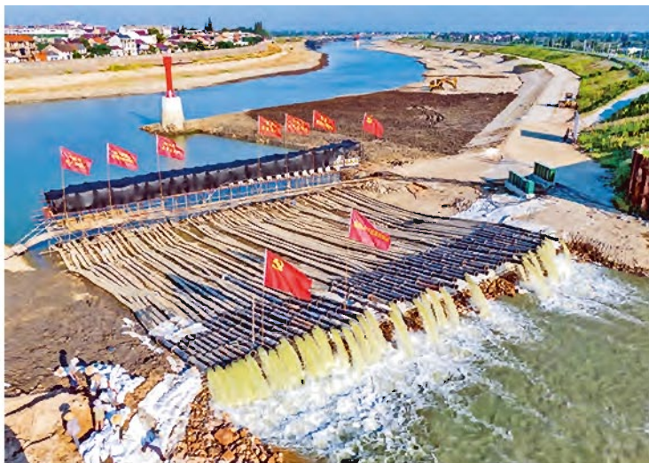
8月15日，在固城湖水碧桥河口，50台临时架设的大型水泵，紧急由水阳江向固城湖补水（程仁虎 摄）
