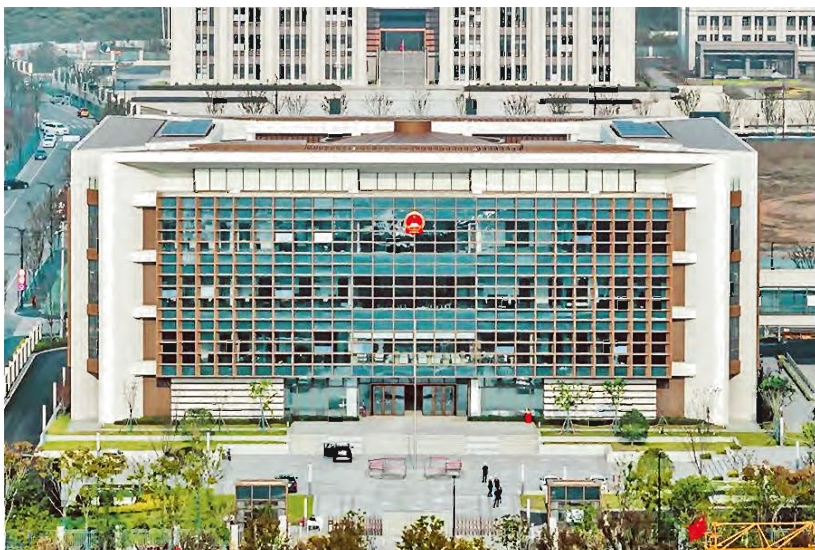
11月11日，江北新区法院新审判综合楼通过竣工验收（金婧 摄）
