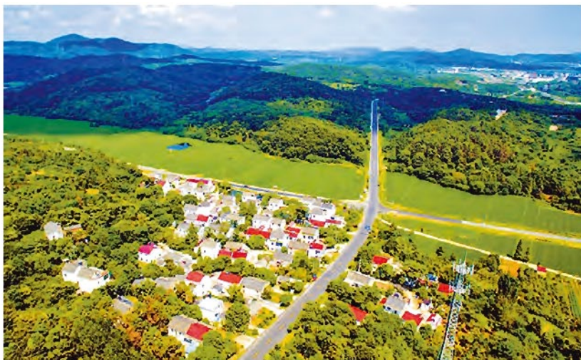
溧水区晶桥街道乡村景观大道
