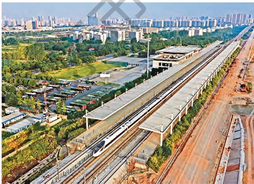
7月17日，南沿江城际铁路引入江宁站站场轨道改造工程完工
