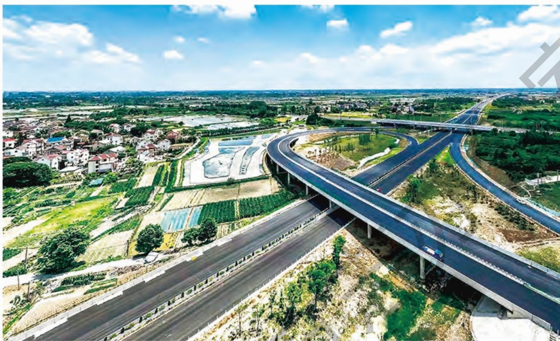
2022年，南京围绕“以城市群、都市圈为依托构建大中小城市协调发展格局”，进一步增强辐射南京都市圈功能。图为9月10日正式通车的宁宣杭高速公路江苏段（阮忠 摄）
