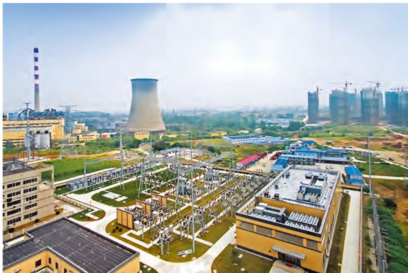
南京供电公司的UPFC基地
