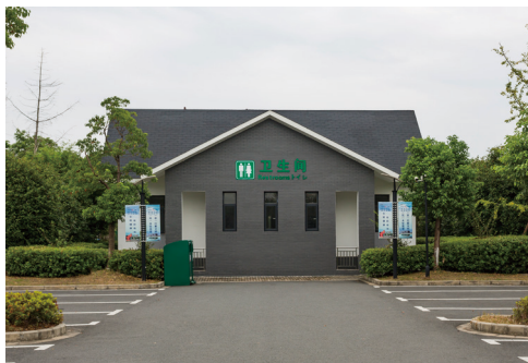
水西停车场公共卫生间
