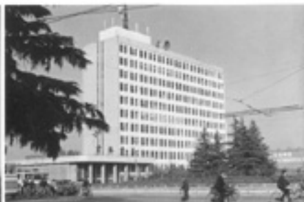
△南京电信枢纽大楼
