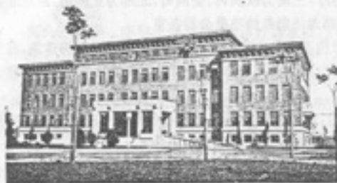
国民政府外交部办公楼立面
