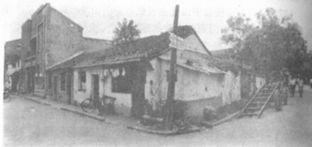
中山东路中段南侧改造前
