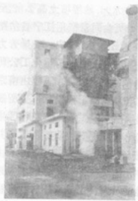
南京新蕾化工公司自备电厂 更衣室、值班室等。
