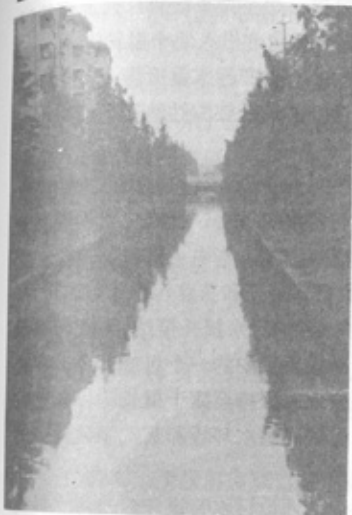
南湖新村排水工程
