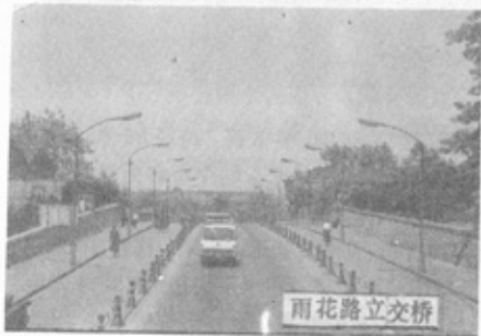
雨花路立交桥
