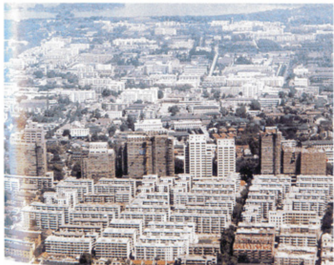
▽ 改造后的中山东路中段南侧
