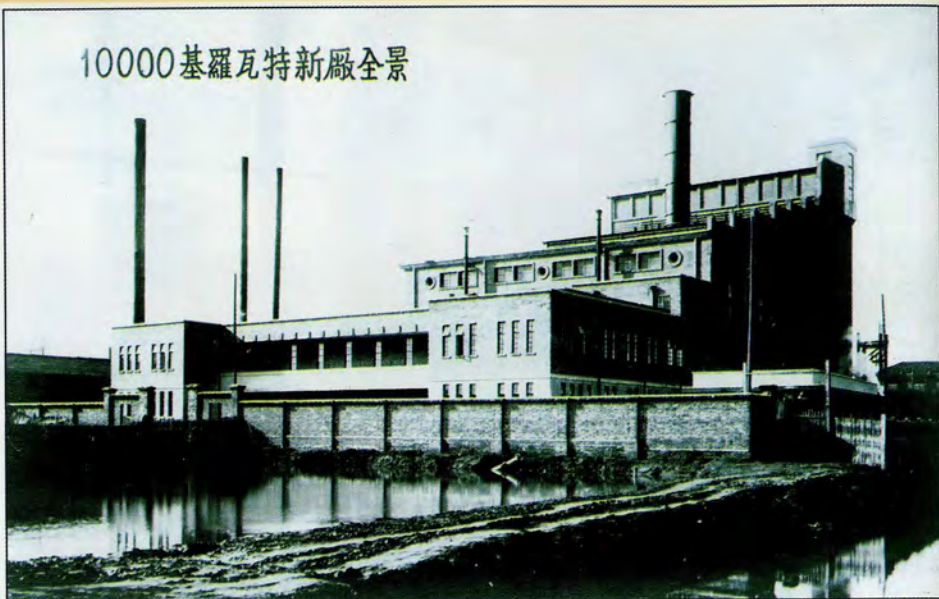
1936年,首都电厂下关发电所1万千瓦发电机组新厂全景
