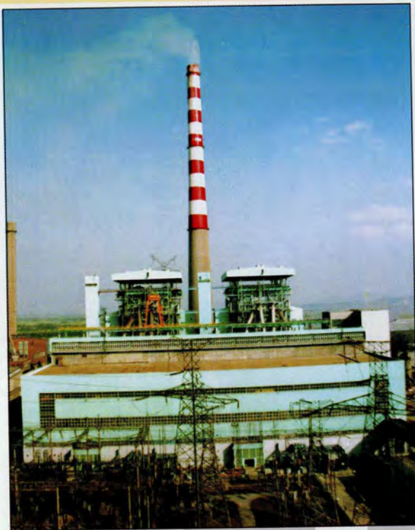
华能南京电厂主厂房
