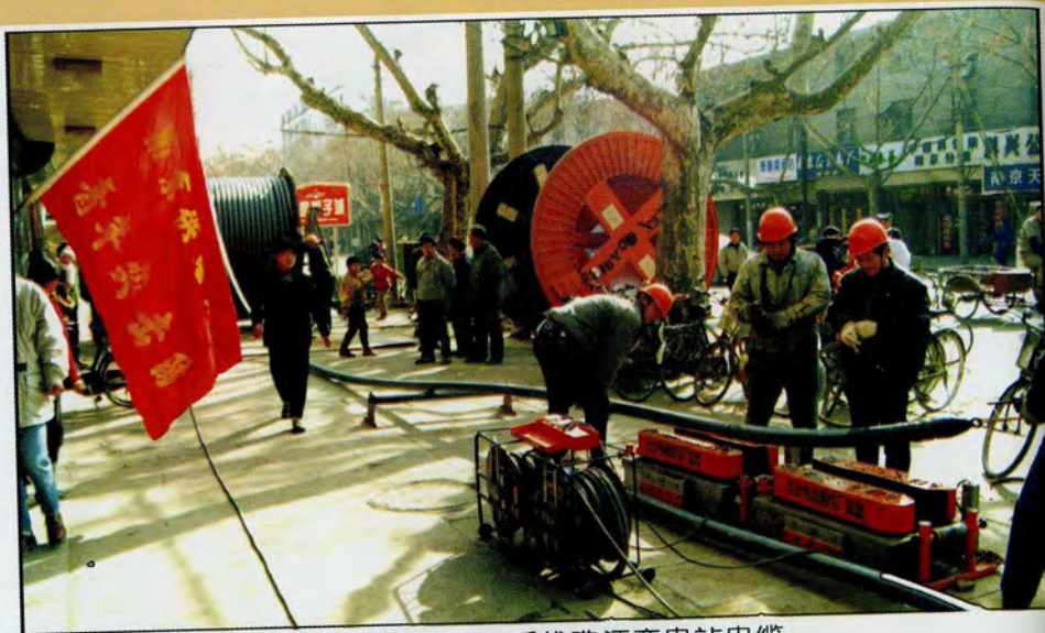
1996年1月,施工人员施放110千伏珠江变电站电缆
