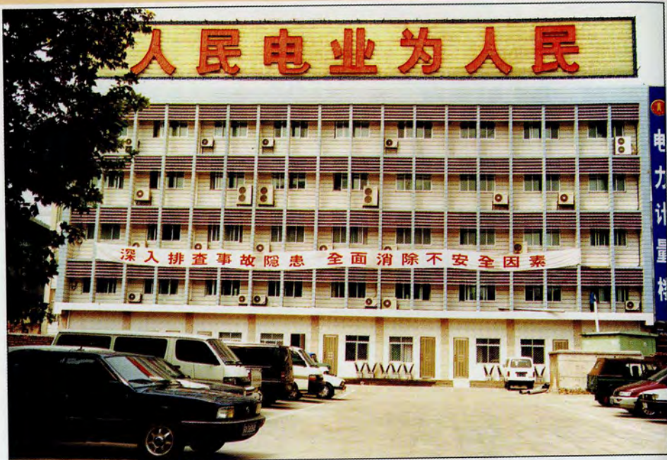
南京供电局电力计量楼
