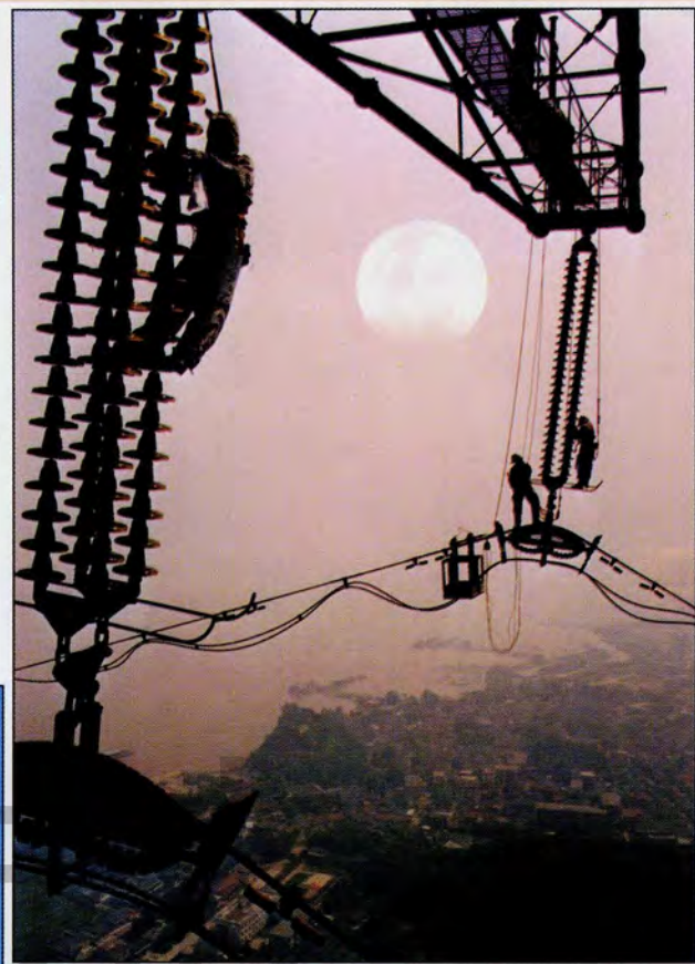
南京供电职工在220千伏跨江线上进行带电作业
