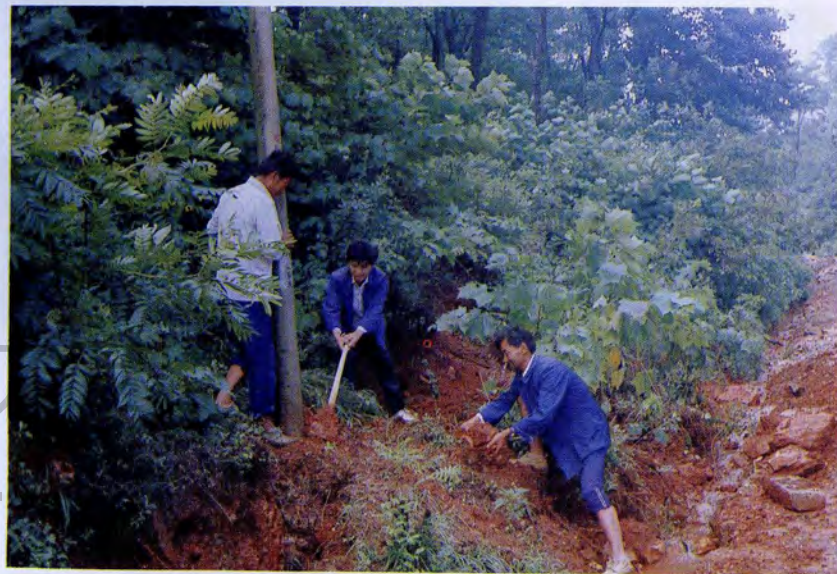
▲江浦县广播电视局施工人员正在架设有线广播网路
