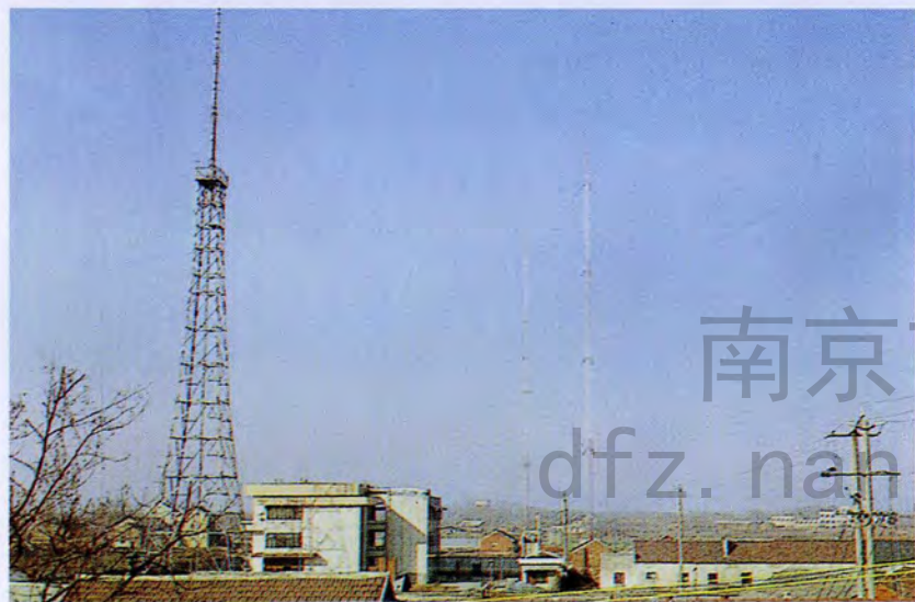
▲1986年9月26日南京电台启用新建的中波发射天线，高120米
