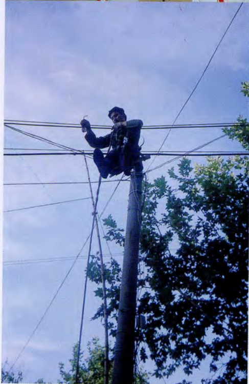
▲南京有线广播电视台工程技术人员架设网络线路
